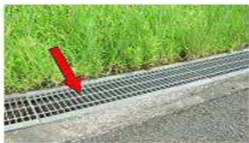
排水溝のふたの裏や側面
