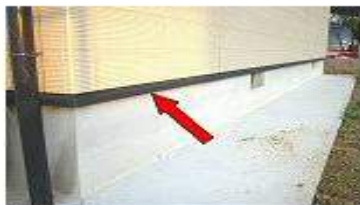
建物基礎に設置された水切り板の裏
